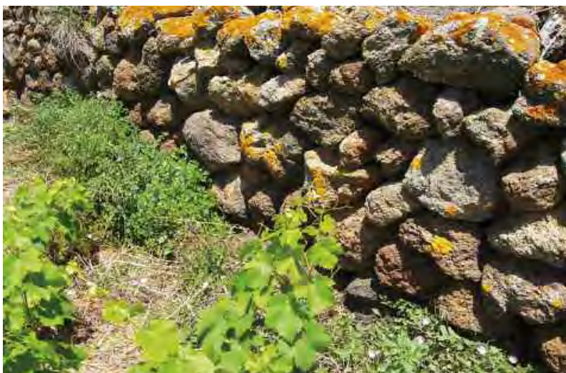
Fig. 2.4.2.5 Costruzione con pietra lavica arrotondata (monte Gibebe, Pantelleria).
