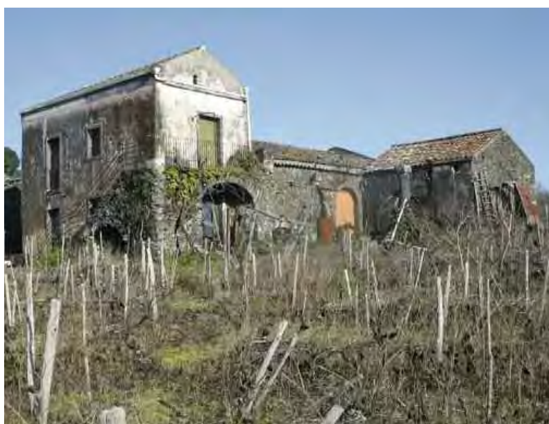
Fig. 2.3.2.15b Abitazione di tipo complesso, dai volumi articolati, con presenza di più abitazioni bicellulari modeste e compatte, disposte in linea o attorno ad una corte semplice scala esterna, e ballatoio su archi non comunicanti (versante E).
