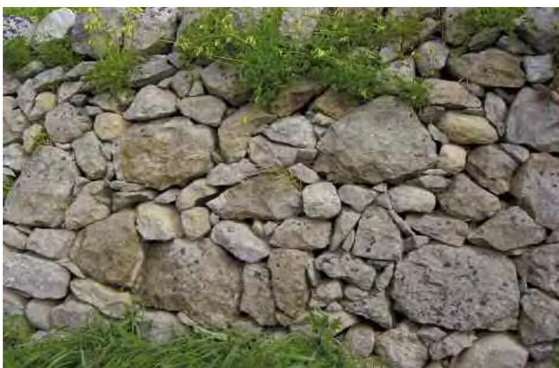
Fig. 2.4.2.6 Costruzione con pietra calcarea di dimensioni diverse (monti Iblei).
