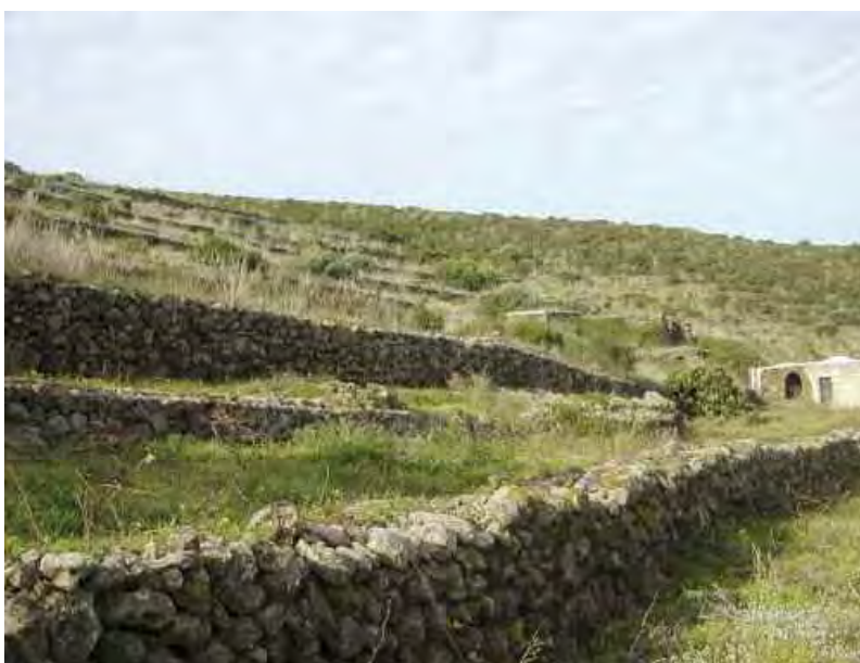
Fig. 3.3.27a Serie di muri a secco a sostegno di terrazze, Pantelleria.
