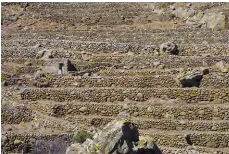
Fig. 3.4.4 I muri di sostegno di terrazzamenti curati in terreni coltivati non mostrano crolli (Foto: M. SCHNITTLER).
