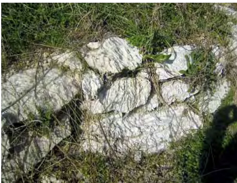
Fig. 2.3.5.6 Muro di sostegno di terrazzamento in materiale gessoso.
