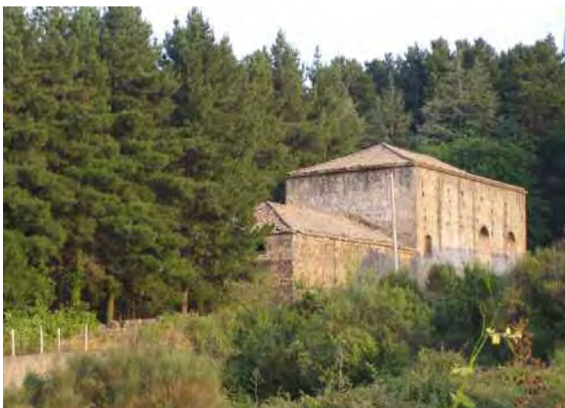
Fig. 3.2.8 Vigneto - Palmento. Si notino i volumi sfalsati in altezza con la cantina in basso dove si raccoglie il vino per caduta, Castiglione di Sicilia.
